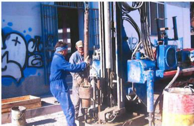
Ubicazione sondaggio S.1
