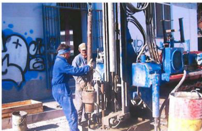
Ubicazione sondaggio S.1
