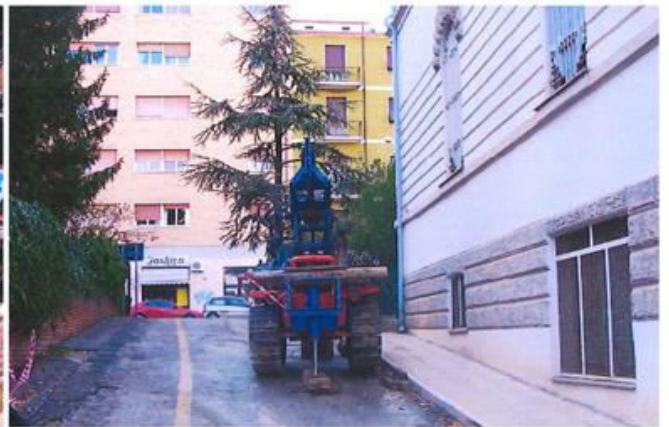
Ubicazione sondaggio S.2
