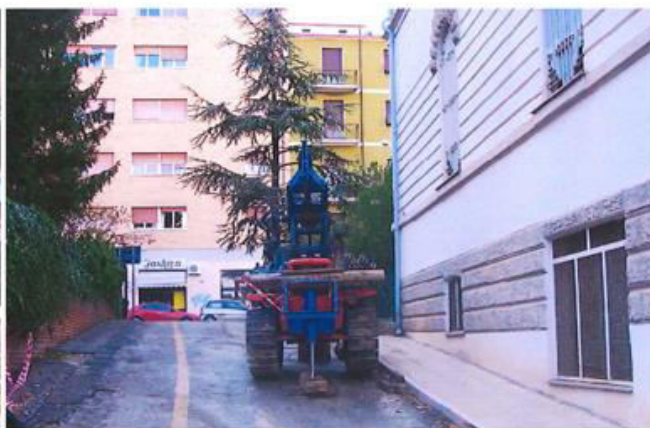
Ubicazione sondaggio S.2
