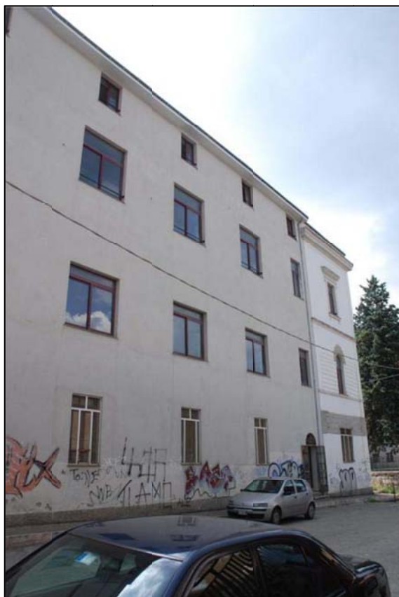
Prospetto posteriore dove le diverse finiture identificano due Unità Strutturali distinte.
