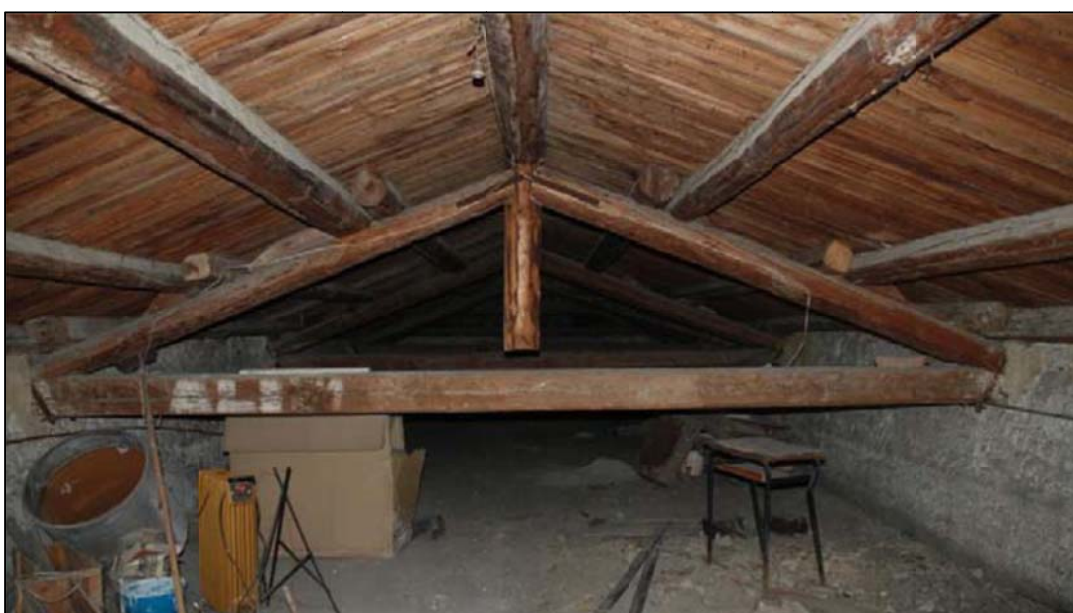
Capriata in legno in copertura
